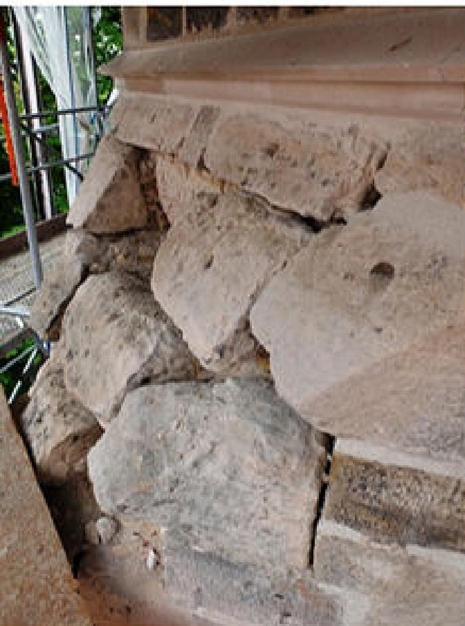
Die Gesimssteine über dem Zwickel sind bereits erneuert. Das Bild unten gibt einen Eindruck von der Verwitterung des ursprünglichen Gesimses.
