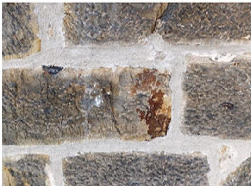
Die Wände im achteckigen Teil des Turmes wurden mit Stahlankern in den Fugen gesichert, damit die Bauteile über Eck sich nicht weiter auseinanderspreizen können. Die Ankerseile sind bereits verfugt. Über die Kunststoffschläuche wird nun noch ein spezieller Mörtel in innere Hohlräume gepresst, damit die Wand auch von innen her stabilisiert wird.
