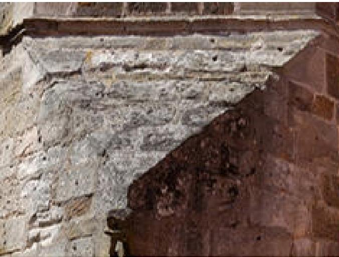
Links oben der Mauerzwickel an der Süd-Ost-Seite des Turms vor Sanierungsbeginn. Unten sieht man den aktuellen Zustand: hier zeigten sich Hohlräume und poröse Steine. Der Neuaufbau dieser Turmecken Süd-Ost und Nord-Ost wird aufwändig!
